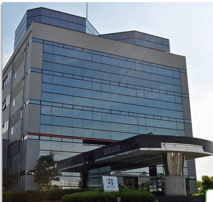
ワコム本社（事務棟、埼玉県加須市）
